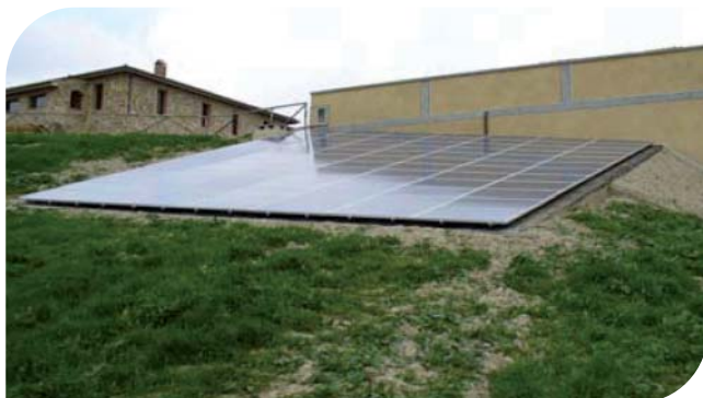
Committente Tenuta Vitanza (SI) Impianto fotovoltaico connesso in rete da 20 kWp
