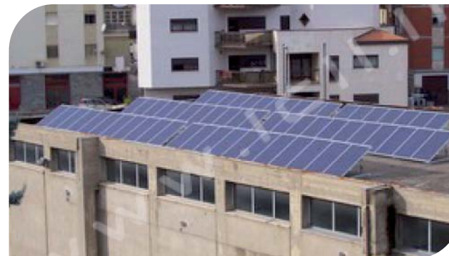
Committente Comune di Matera Impianto fotovoltaico connesso in rete da 10 kWp presso Scuola De Matera Cosenza
