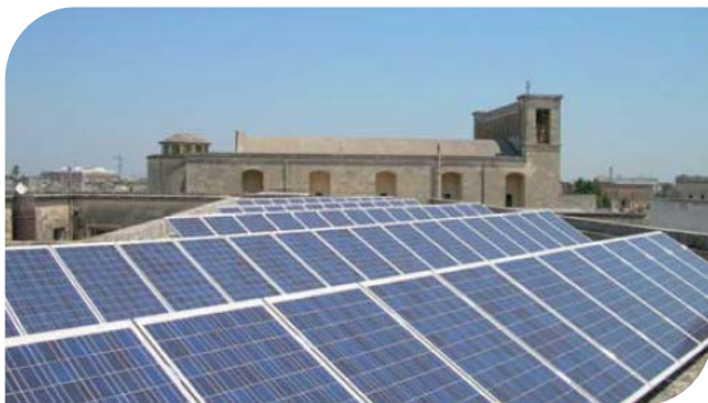
Committente Comune di Maglie (LE) Impianto fotovoltaico connesso in rete da 11 kWp, presso Scuola Media di Via Armando Diaz
